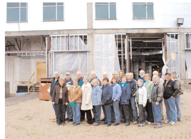
Des membres du conseil et du personnel de l'HGNB ont visité le chantier de construction. Le centre devrait être achevé à l'été 2010 et on devrait y emménager à l'automne 2010.
